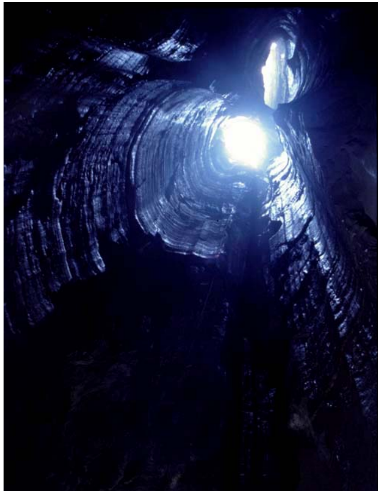
LA GRAJERA, POZO 185 m
